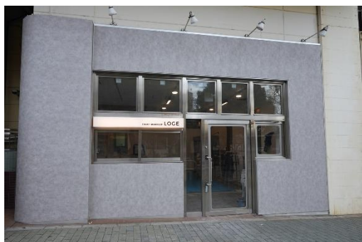
<「FORT MARKET LOGE」外観>
