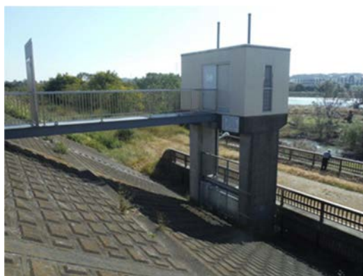
写真 1 猪方排水樋管
