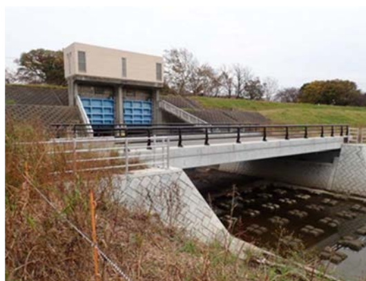
写真 3 六郷排水樋管
