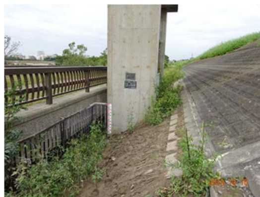
写真 2 猪方排水樋管水位痕跡
