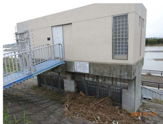
写真 4 六郷排水樋管水位痕跡
