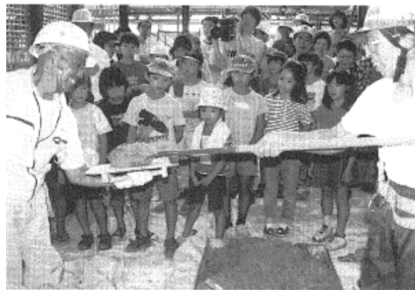
平成13年8月 土壁塗り
