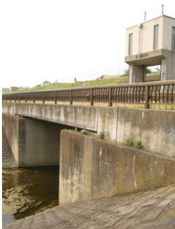
図-1.1 分流雨水放流渠 きよ (猪方排水樋門・駒井町3丁目)
