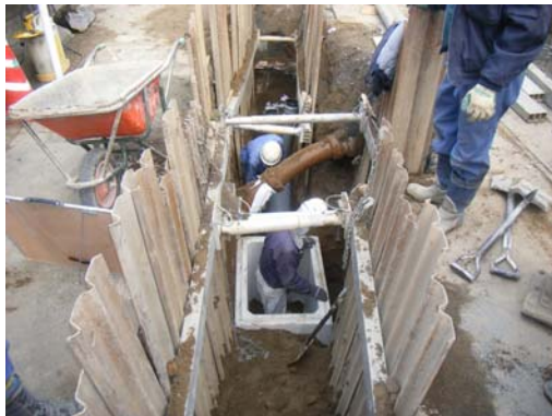
図-10.1 雨水管渠の施工状況
