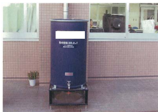
図-12.4 雨水貯留施設 (タンク)
