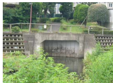
図-1.2 越流水放流渠 きよ （世田谷区）
