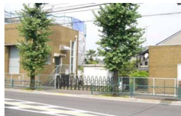
図-1.3 中継ポンプ場（東和泉1丁目）
