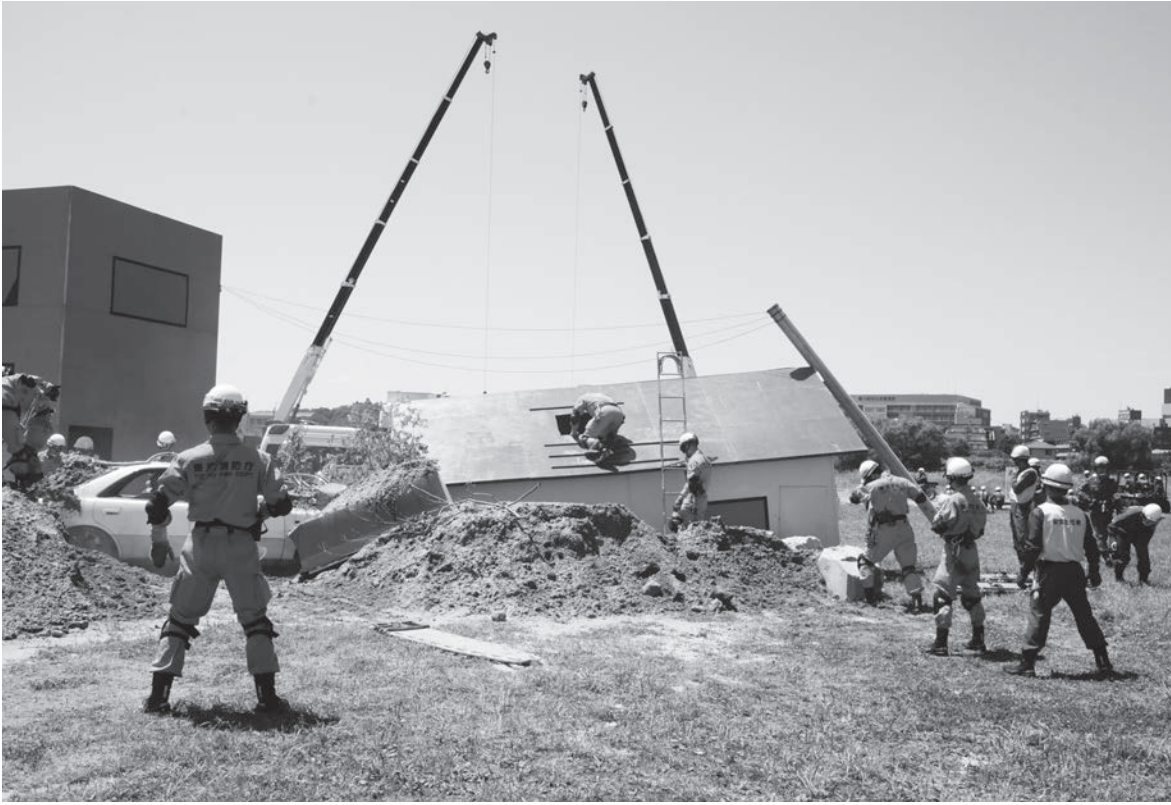
— 平成27年度 東京消防庁・狛江市合同総合水防訓練 —
