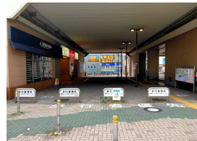
高架下商業施設の入り口
