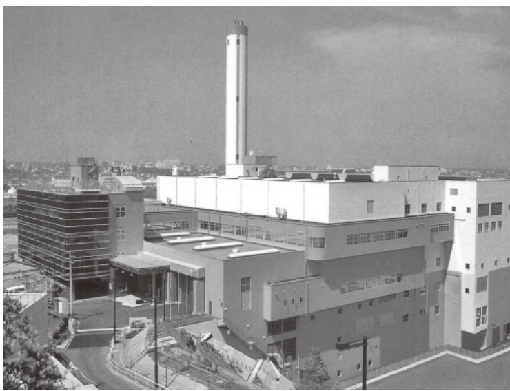
■クリーンセンター多摩川 多摩川衛生組合(狛江市・稲城市・府中市・国立市で構成する一部事務組合)が運営するごみ処理施設。 ※ホームページ http://www.union-tamagawa.jp/ 予約は電話でお願いします。
