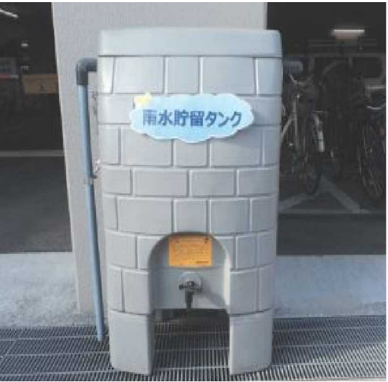
雨水貯留タンク
