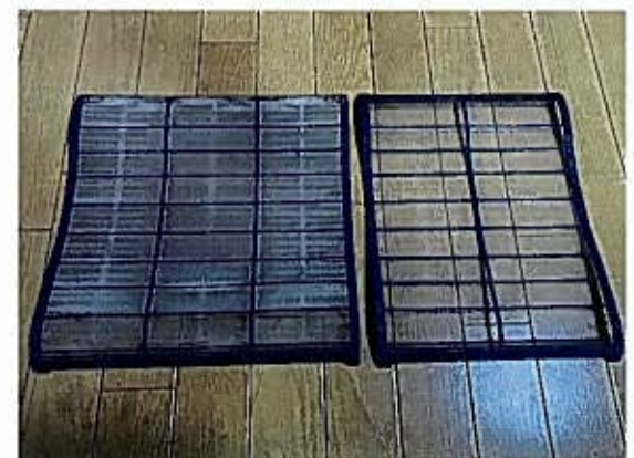
図7 エアコンのフィルター 左が掃除前、右が掃除後
