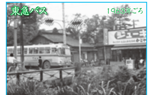
二の橋付近を走る東急バス。左は狛江・渋谷間を走った25系統のバスの側面に付けられた行先板
