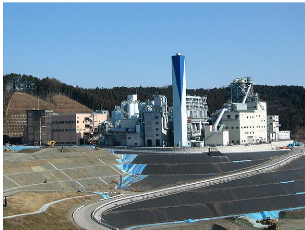
【エコセメント化施設】
