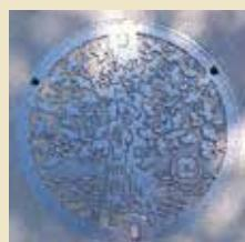
合流マンホールは、雨水と生活排水などの汚水を一緒に流すための下水道管を管理するためのものです。
