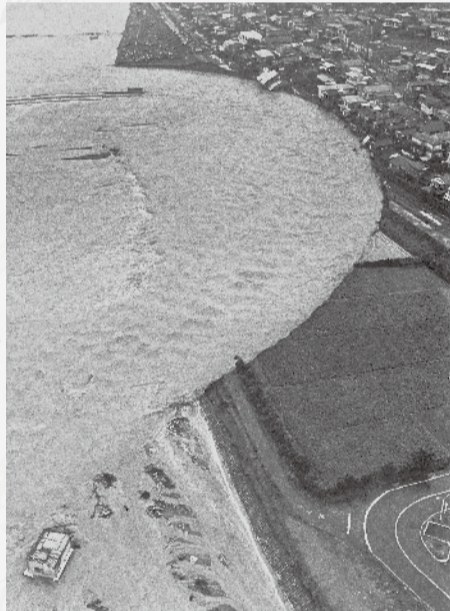
▲濁流に「く」の字にえぐり取られた多摩川の堤防=1974年9月2日午前7時20分、狛江市の「多摩川堤防決壊記録」
