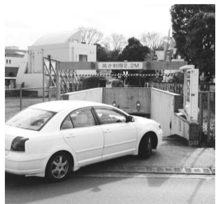
狛江駅北口地下駐車場入口
