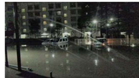
西和泉地区の浸水状況 (13日0時頃)
